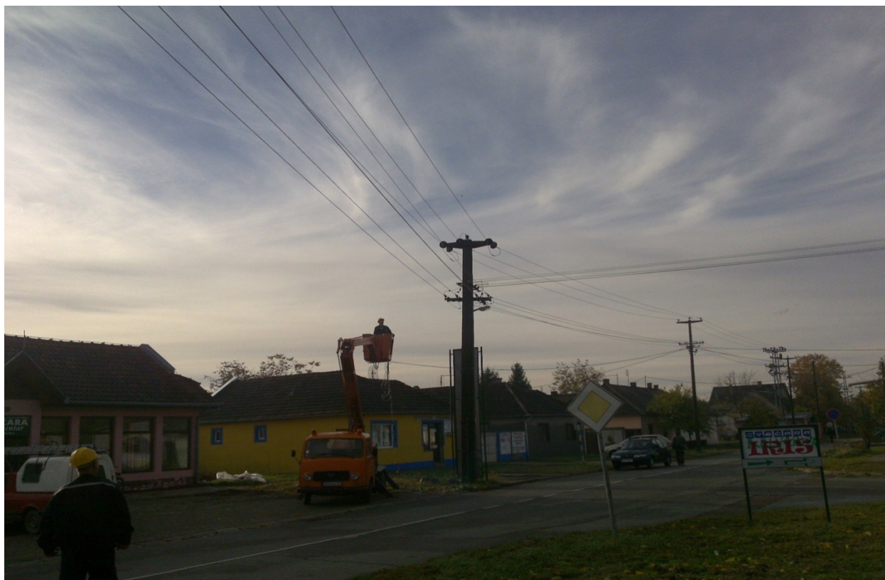
Slika 1. Razvezivanje i uzemljavanje provodnika
