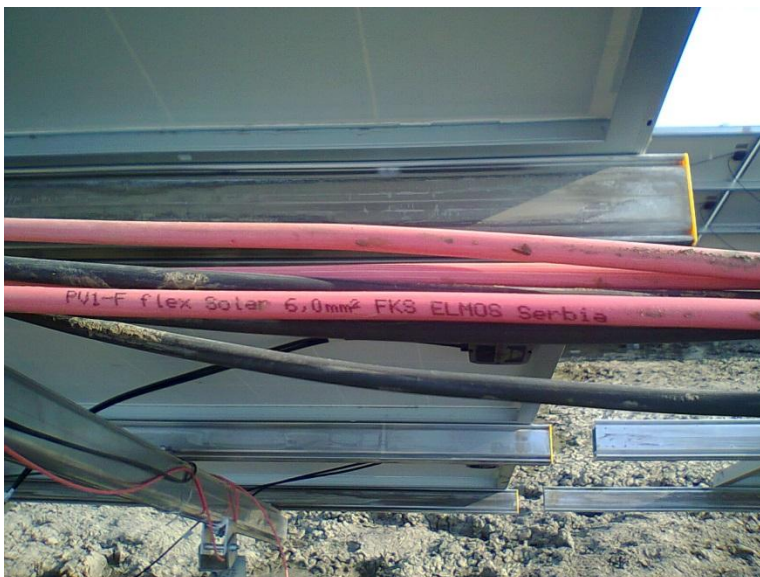
Слика 8. Проводник за соларне системе ознаке PVI-flex, фирме „FKS ELMOS“ из Јагодине
