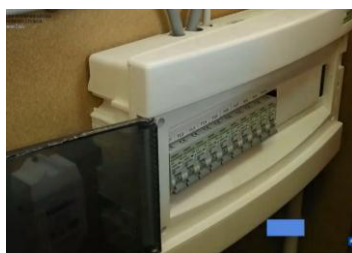
Слика 6. Разводна табла са аутоматским осигурачима
