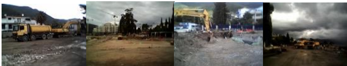
Slika 5: Priprema terena za početak izgradnje Marina Apartments 1 u Portonovom 2016.godine [2]
