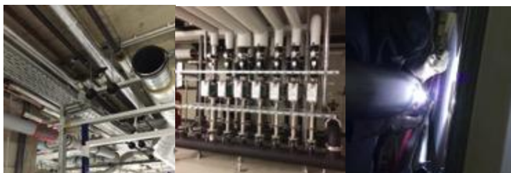
Slika 3: MEP instalacije na zgradi Marina Apartments 1 tokom 2019. godine [2]
