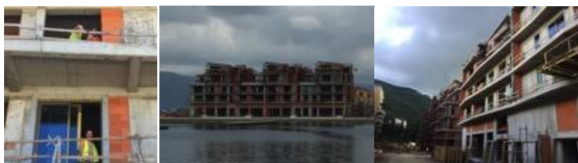
Slika 2: Ugradnja stolarije na zgradi Marina Apartments 1 tokom 2018. i 2019. godine [1]
