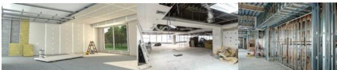
Slika 3: Unutrašnji završni radovi na zgradi Marina Apartments 1 tokom 2019. godine [3]
