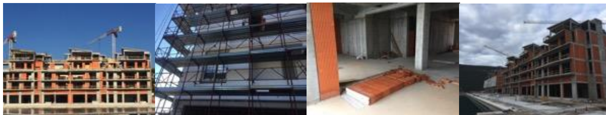
Slika 1: Zidarski i fasadni radovi u Portonovom 2018.godine [1]
