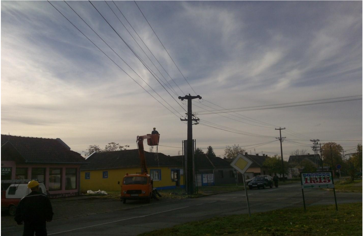
Slika 1. Razvezivanje i uzemljavanje provodnika
