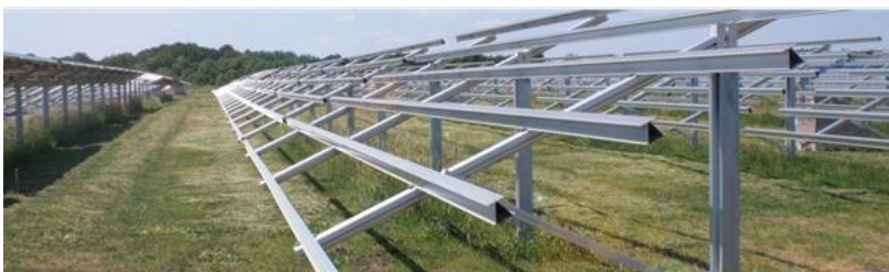
Слика 3. Носећа конструкција од алуминијума пре монтаже соларних панела
