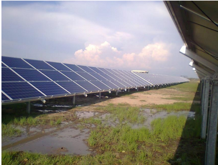
Слика 4. Соларни панели по завршетку монтаже на носећу конструкцију
