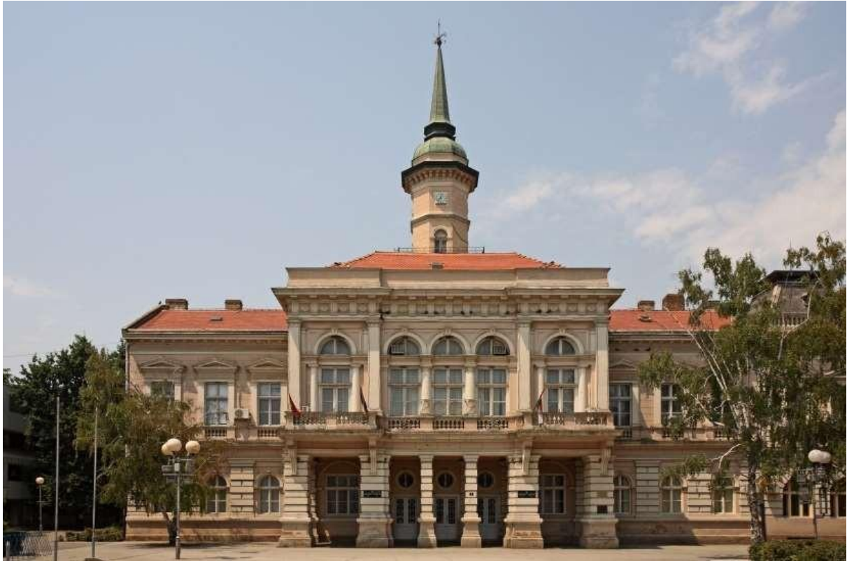
Слика 2: Зграда Скупштине општине Бечеј
